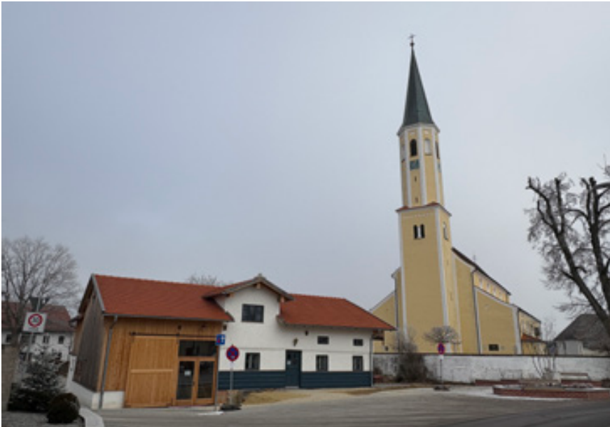
Das frisch renovierte Trillerhaus neben der Kirche kurz vor Fertigstellung.
