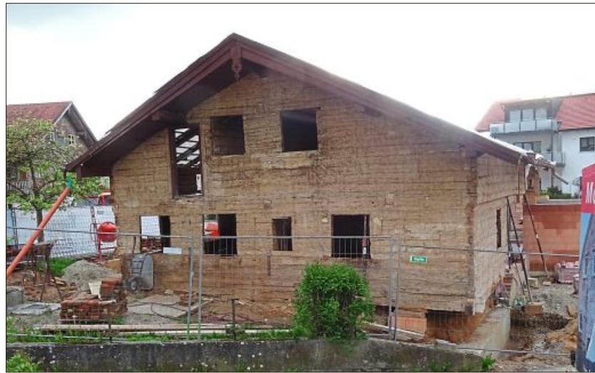
Während des Umbaus wurde das Trillerhaus unter anderem auf ein neues Fundament gestellt.
