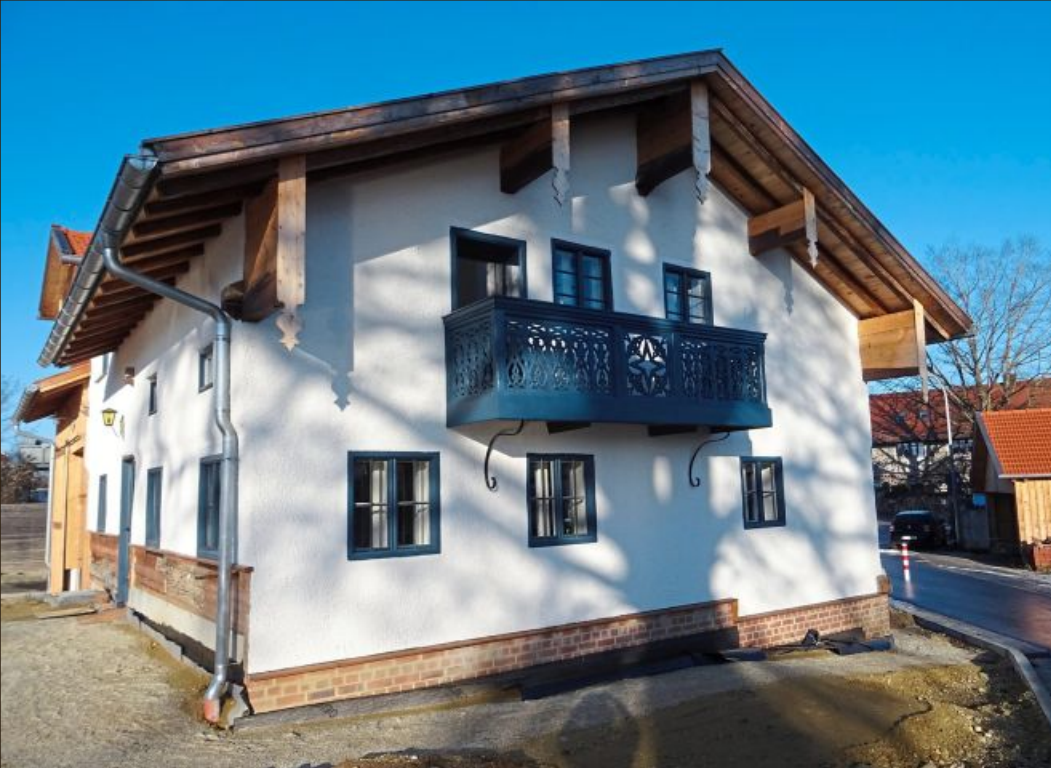
Blickfang des sanierten Trillerhauses ist der prächtige Balkon mit seinen Verzierungen.
