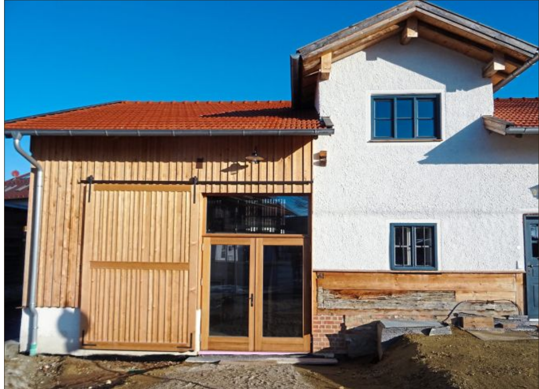
Außenansicht des neuen Kulturstadels.
