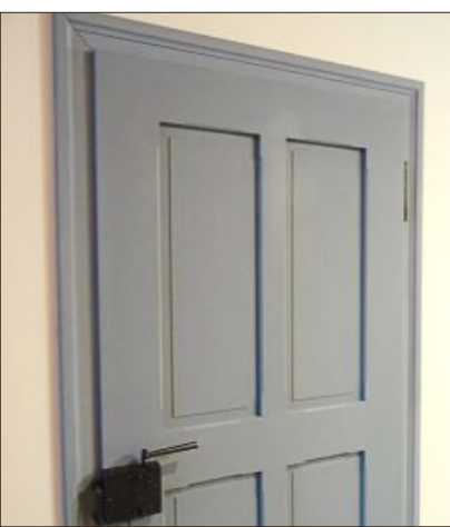
Die alten Türen wurden im originalen Farbton restauriert.
