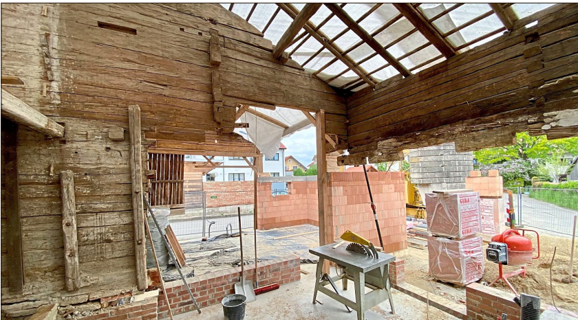
So sah es am Ortstermin vergangenen Freitag aus: Manche Außenbalken waren so marode, dass Handwerker sie abgerissen haben. Im Nordwest-Eck entstehen neue Wände. Dort sollen die Adlkofener bald Wurst oder Käse kaufen können.
