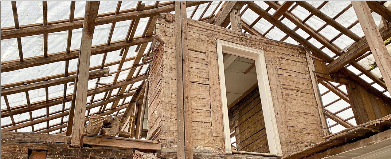
Der Holzblock im Trillerhaus bleibt denkmalgerecht erhalten. Eine neue Treppe soll in den ersten Stock führen. Dort könnte eine Pflegekraft für unten lebende Senioren unterkommen, so die Vorstellung der Eigentümer. Fotos: Matthias Keck
